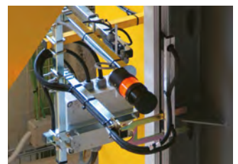
SEÑAL LUMINOSA Y ACÚSTICA
