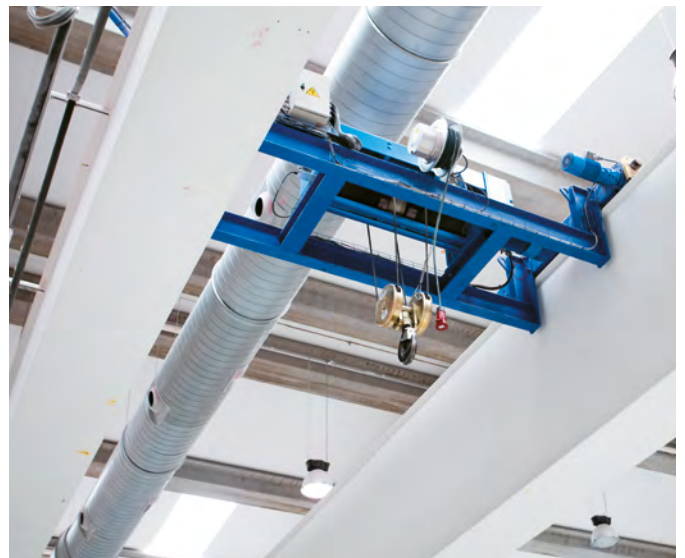
CARRO ACUNADO ENTRE VIGAS
