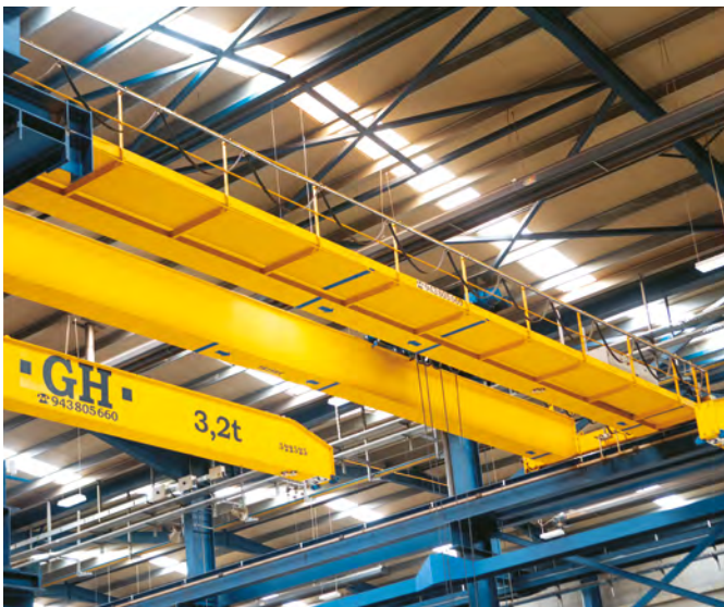
PASILLOS DE MANTENIMIENTO. PLATAFORMAS EN CARRO.
